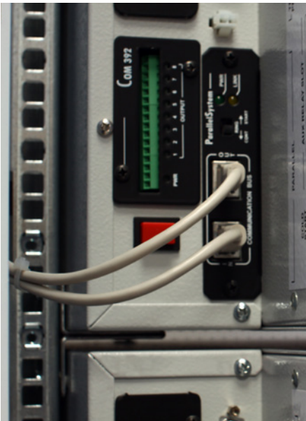
Parallelanschluss und Platine mit programmierbaren Relaiskontakten
